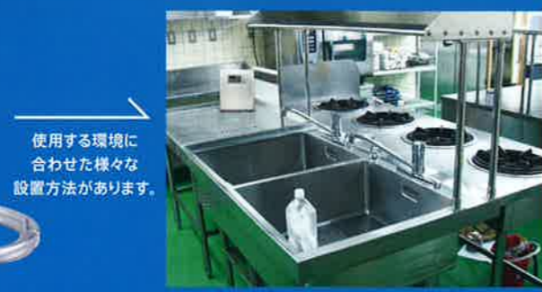
生成装置本体 (KCL) 食塩水タンク
